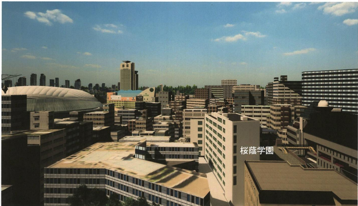
本館南側(建設前)
