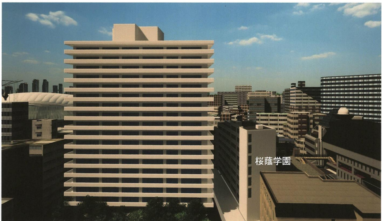
本館南側(建設後)
